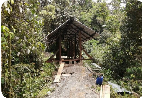
Reparación del puente peatonal sobre el río Kalaglás paso al sector Chone
