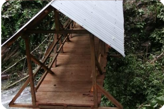
Reparación puente peatonal sobre el río Akerones que comunica el centro parroquial de San Carlos y la comunidad de Kutukus
