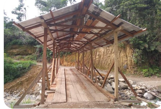
Reparación del puente peatonal sobre el río Yanguza paso a San Luis de Miachi. comunidad 27 de noviembre
